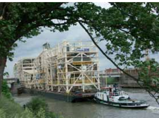
2006 | Transport d'un module pré-assemblé pour une aluminerie - Fjardaal (Islande)
