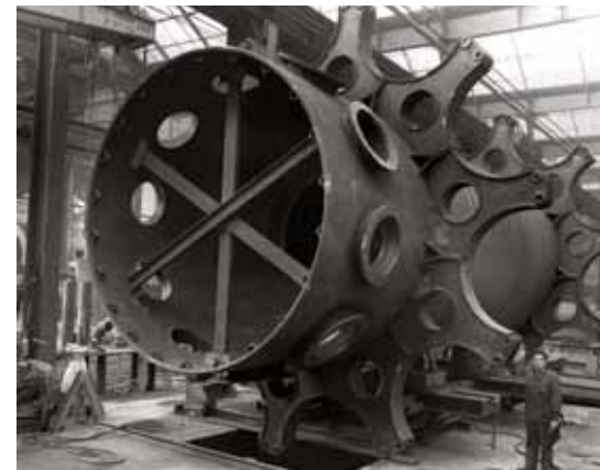
1960 | Extrémité d'un four rotatif pour la cimenterie d'Atchinsk en Sibérie
